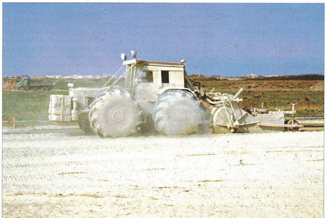
Vermörtelung des Füllsandes mit einer Spezialmaschine.
