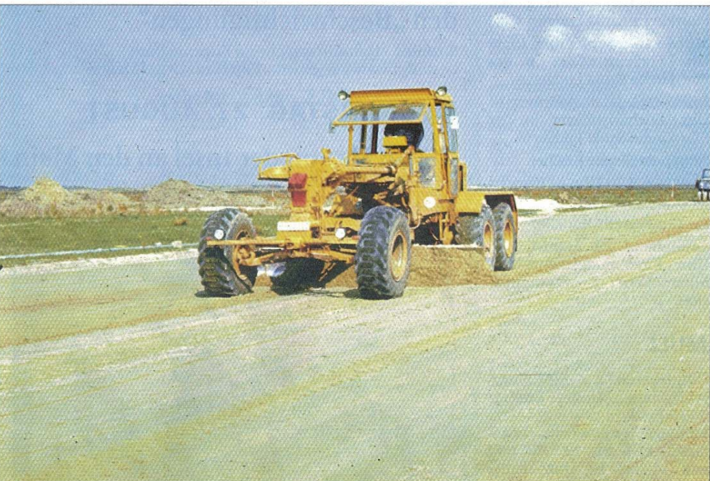
Planierung des Füllsandes auf der Start- und Landebahn.
