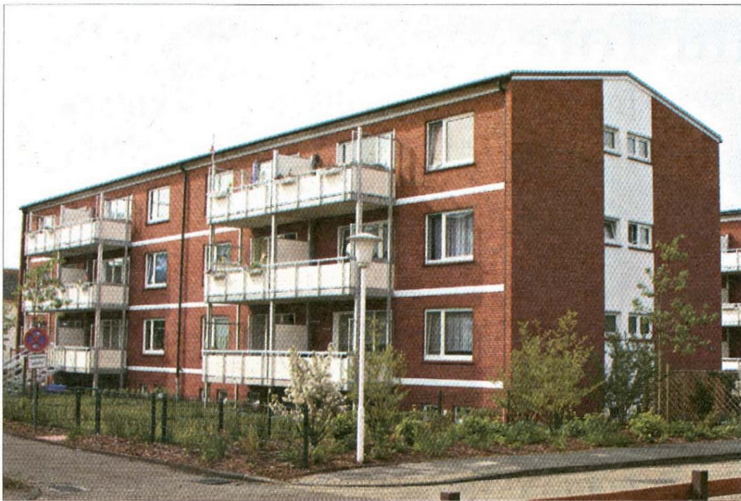
Mehrfamilienhaus „Am Wasserturm“ mit neuen Balkons.
