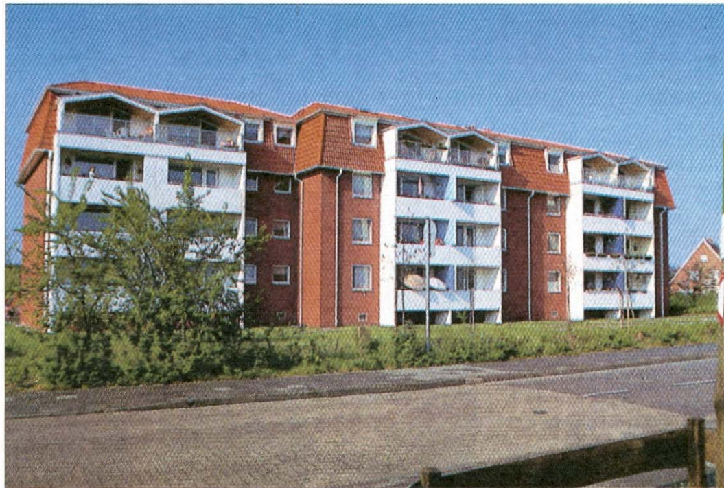
Aufstockung mit dem Mansarddach – „Lüttje Leegde“.
