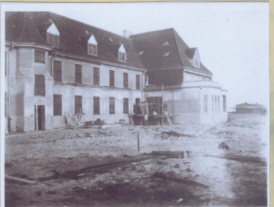
Das Gebäude kurz vor der Fertigstellung. Ansicht von Süden aus gesehen.
