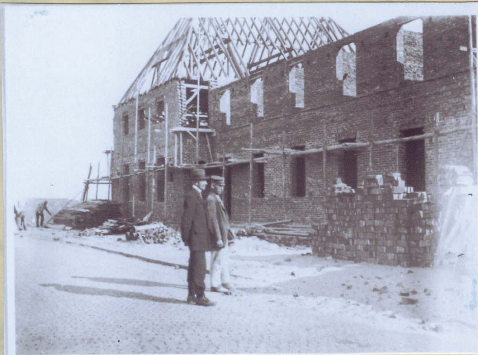
Rohbau von Norden aus gesehen. Die alte Hafenstraße führt direkt am Gebäude vorbei.
