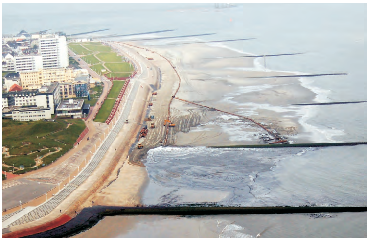
Abb. 5: Westkopf der Insel Norderney mit der Spüleitung der Strandaufspülung 2007
