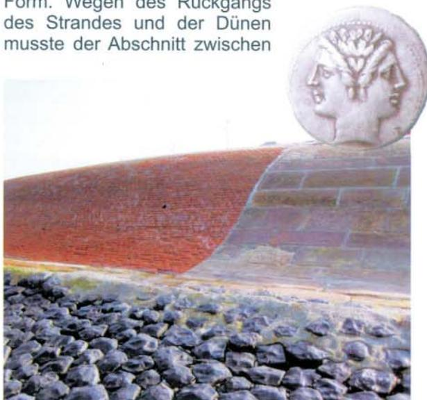
Abb. 3: Deckwerkssystem aus roten Klinkerstein und Sandsteinblöcken, römische Münze mit Janus-Kopf
