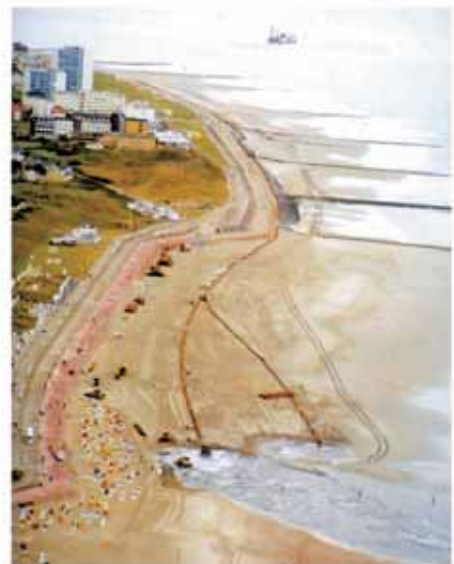
Abb. 5: Westkopf der Insel Norderney mit der Spüleitung der Strandaufspülung 2000
