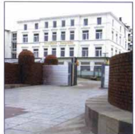
Deichschart Moltkestraße: ein Bollwerk gegen Sturmfluten
