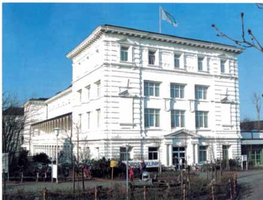
Nordseeklinik I (Hauptgebäude) Bülowallee 6
