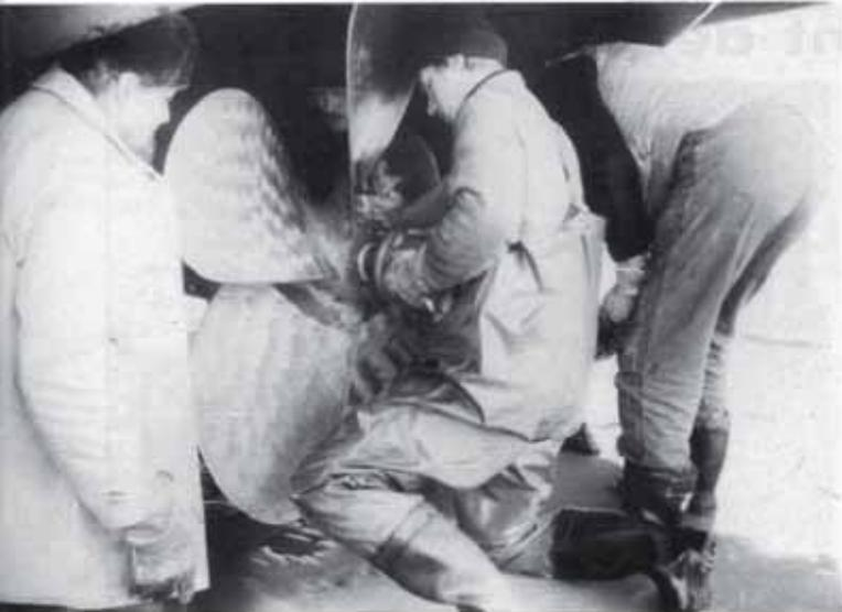
Montage des fünfflügeligen Hauptpropellers der „FRISIA V“.
