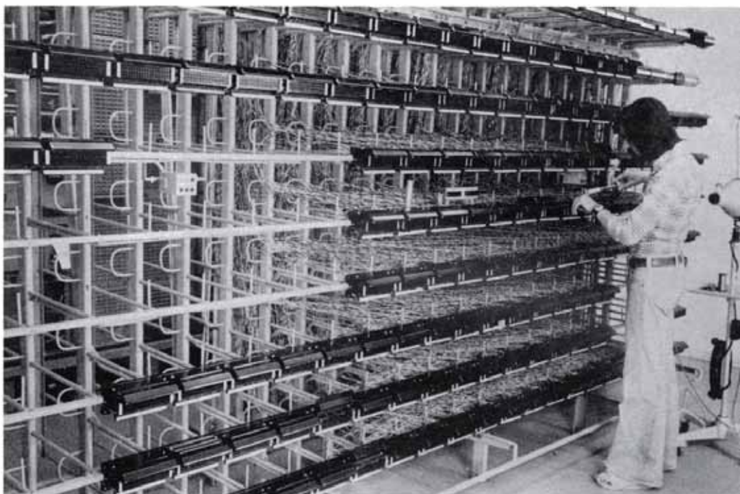
Der Hauptverteiler im Norderneyer Postamt.
