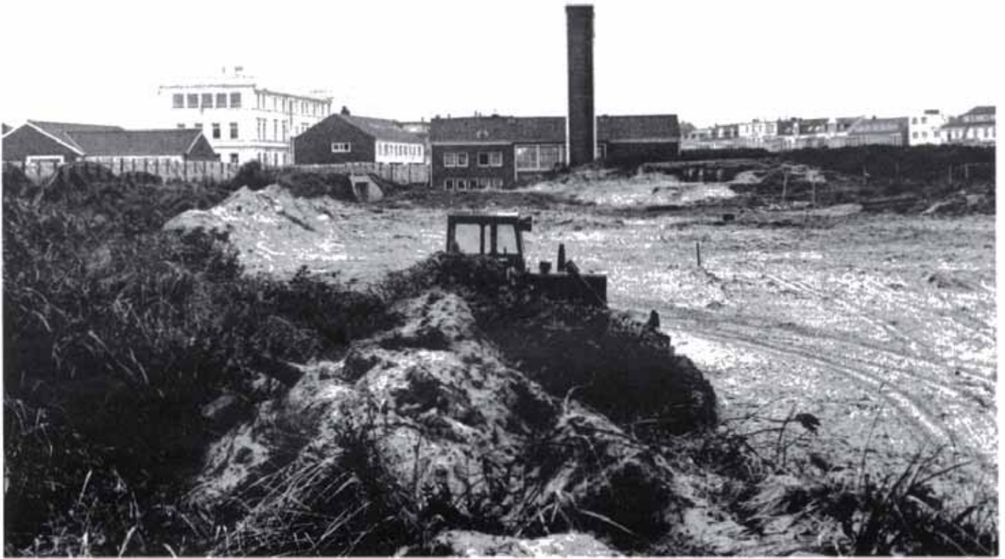
Start zum Bau des beheizten Meerwasser-Wellen-Freibades hinter dem Weststrand
