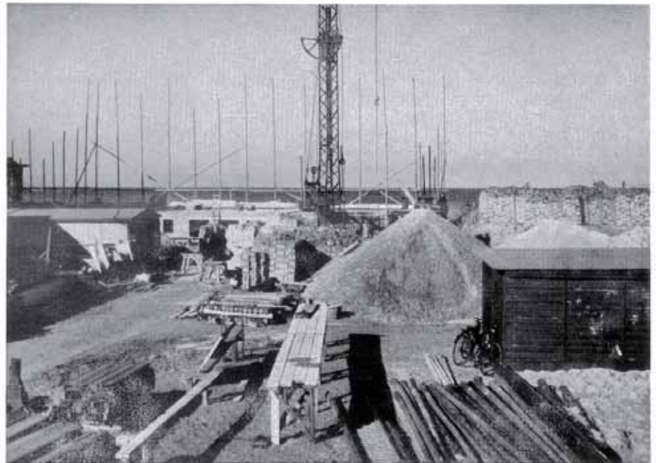
Das Haus „Daheim“ wird um einen mehrstöckigen Hotelflügel erweitert
