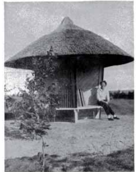
Schutzhütte für Strandspaziergänger und Golfer
